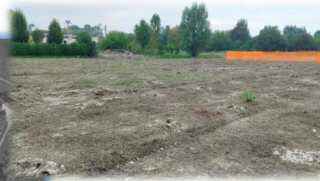
Cantiere lato rig (in sinistra Adige) attività bonifica profonda
